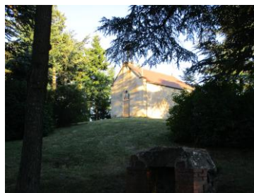
Le site avant la tempête
